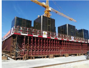
Caisson formwork
